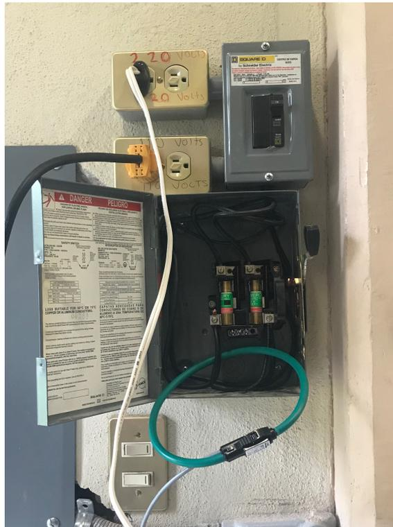
**Figura C.8:** Adaptación de los puntos de conexión donde se realizan las mediciones de potencia. Se puede observar que el transductor de corriente *abraza* el cable por el cual circula la corriente a monitorear y el transductor de voltaje está conectado a la línea de 220 V.
