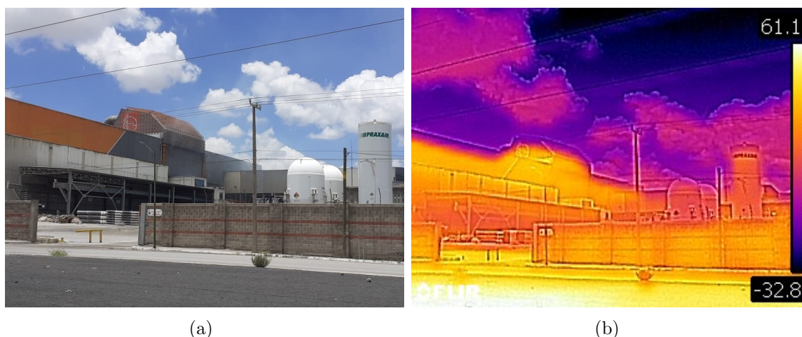
Figura 4.24: (a) Imagen térmica e (b) imagen óptica de la fuente de emisión del Grupo Acerero Fondería .
